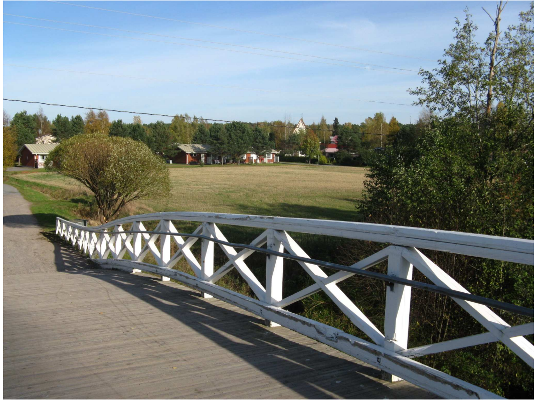
Kuva 1: Näkymä Noormarkunjoen ylittävältä kevyen liikenteen sillalta koilliseen.
