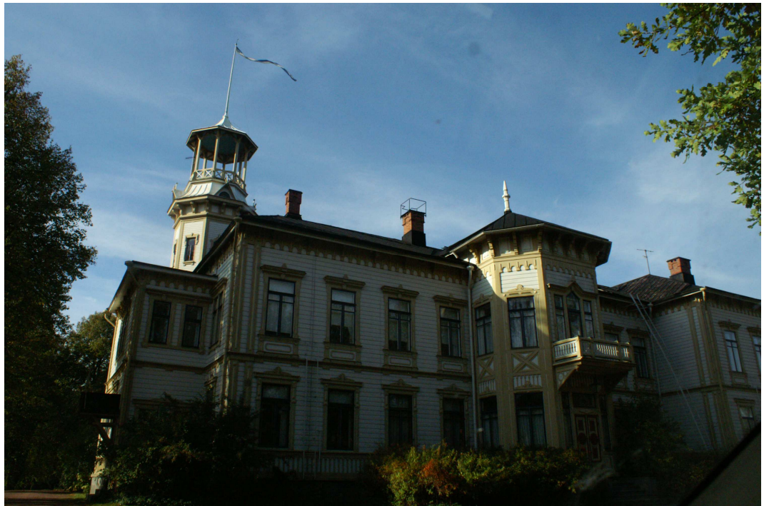
Kuva 5: Ruukin alueella sijaitsevan Isotalon on piirtänyt arkkitehti Evert Lagerpeltz ja se on rakennettu vuosina 1877-1882. Kuva: Mari Seppä, 2010
